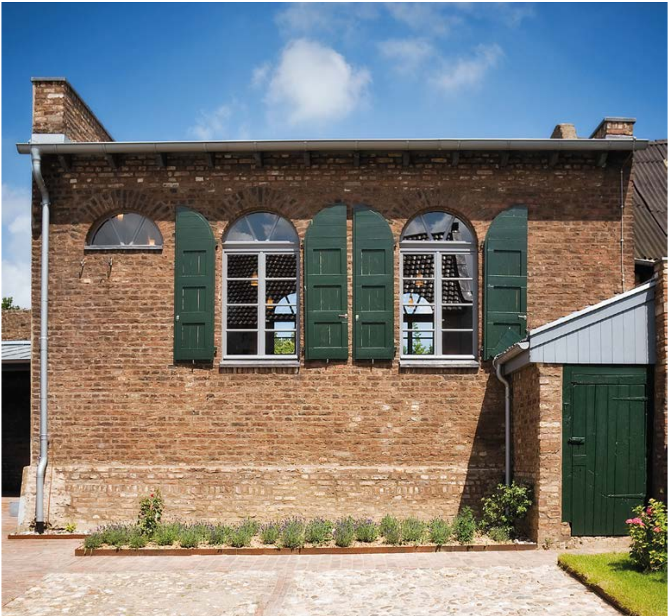
Bild 1 Südansicht der Landsynagoge Rödingen
