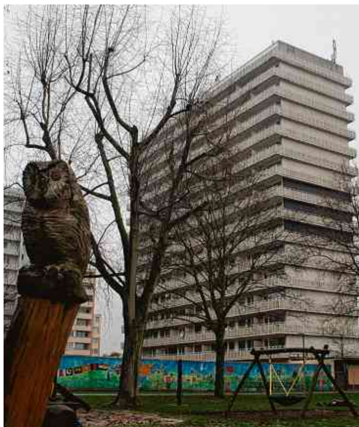
Das Hochhaus an der Albrecht-Dürer-Allee 4-6 soll bis Mitte 2019 aus dem Stadtbild verschwunden sein. Foto: Vlaminck
