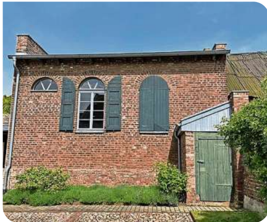
Die Backsteinfassade der einfachen Landsynagoge in Rödingen im Kreis Düren.
