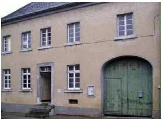
7. Ehemaliges Synagogenvorsteherhaus, Straßenansicht vor Instandsetzung. Foto: Jürgen Gregori, LVR-ADR 2000.
