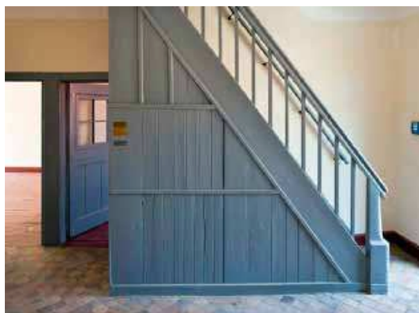
13. Ehemaliges Synagogenvorsteherhaus, Treppe im Herdraum nach Instandsetzung. Foto: Jürgen Gregori, LVR-ADR, 2008.
