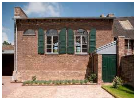
6. Ehemalige Synagoge nach Instandsetzung. Foto: Medienzentrums Rheinland, 2008.
