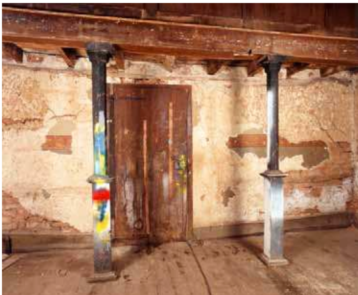
9. Ehemalige Synagoge, Blick auf die Frauenempore, Vorzustand. Foto: Jürgen Gregori, LVR-ADR, 2000.
