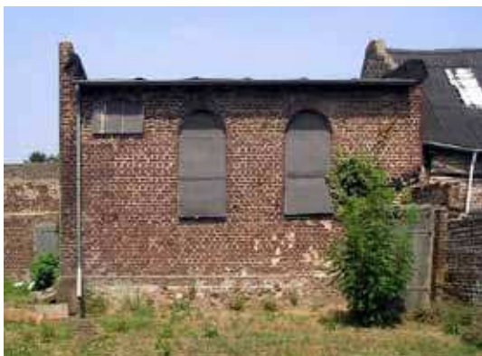
5. Ehemalige Synagoge vor Instandsetzung. Foto: Jürgen Gregori, LVR-ADR, 2000. Foto: Claus Lieven, LVR-ADR, 1985.
