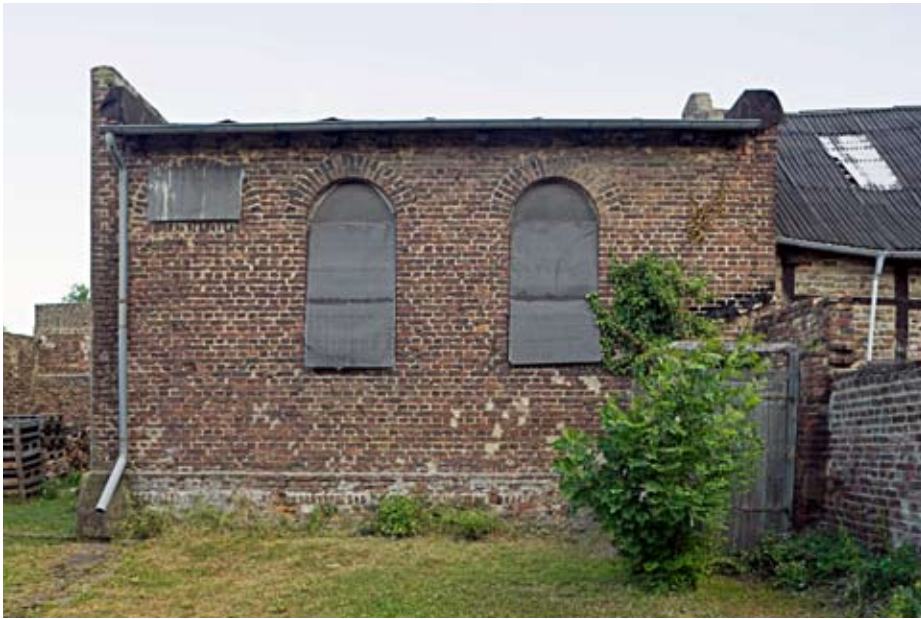
1 Südfassade der Synagoge vor der Sanierung, Sommer 2006
