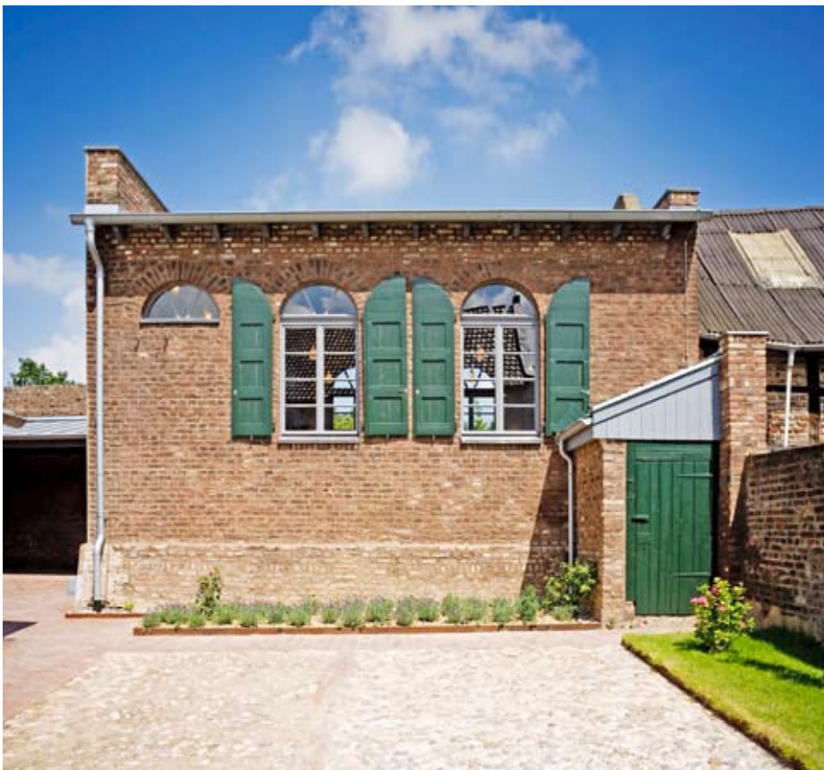
2 Südfassade der Synagoge nach der Sanierung, Sommer 2008
