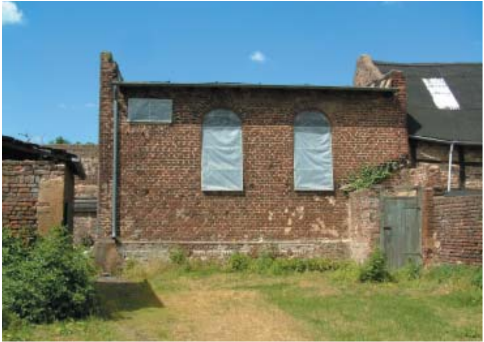
Die ehemalige Synagoge in Titz-Rödingen. Blick vom Synagogenhof auf die Südseite der Synagoge.
