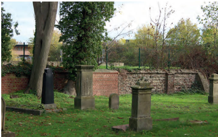
Der alte Friedhof nach Osten. Die Nahtstelle in der Mauer zwischen dem Altbestand und dem 1978 aufgemauerten Abschnitt ist deutlich sichtbar © Thomas Kreft
