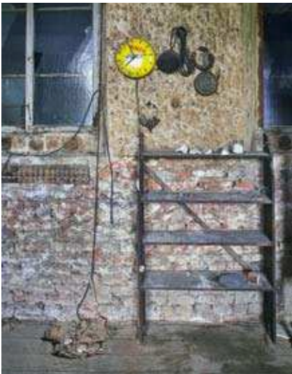
8. Synagoge, Innenwand mit Fenster, Vorzustand. Foto: Andreas Schiblon, LVR-Zentrum für Medien und Bildung, 2000.
