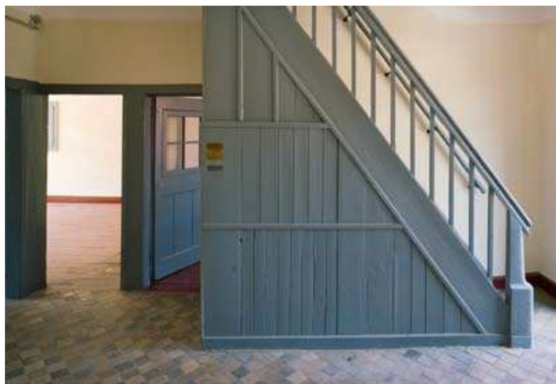
25. Vorsteherhaus, Treppe im Herdraum nach Instandsetzung. Foto: Jürgen Gregori, LVR-ADR, 2008.
