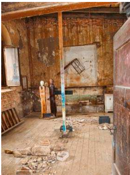
6. Synagoge, Blick auf die Tora-Nische, Vorzustand. Foto: Thomas Ströter, LVR-ADR, 2000.
