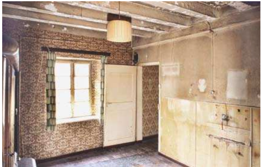
9. Vorsteherhaus, Innenraum, Vorzustand. Foto: Jürgen Gregori, LVR-ADR, 2000.
