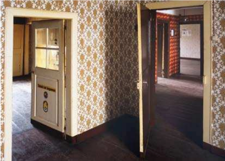
12. Vorsteherhaus, Zimmerflucht, Tapetenbefunde. Foto: Jürgen Gregori, LVR-ADR, 2000.
